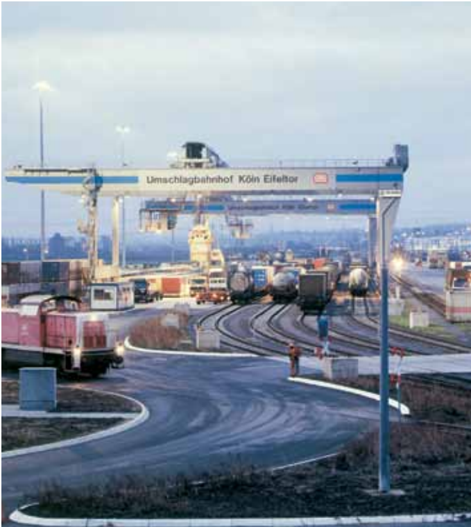
Nagy kiterjedésű berendezésekben, például konténer-pályaudvarokon üzemelő daruberendezéseknél gyakran jelentkezik a hosszú vezérlővezetékek okozta kábelkapacitás problémája.
